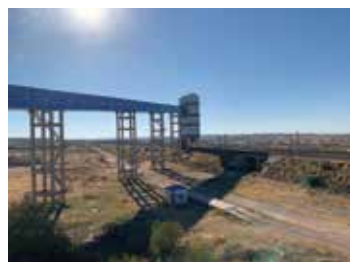
长距离带式输送机及火车装车机
